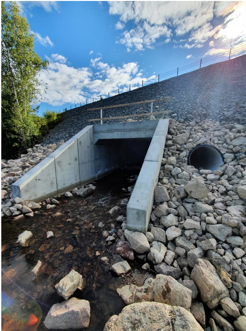
Figur 7. Foto efter åtgärd uppströms bron. Foto taget mot sydväst, på brons inlopp. Foto taget innan mulljorden upp till faunapassagen lagts ut (som visas i Figur 8). (Foto: Afry).
