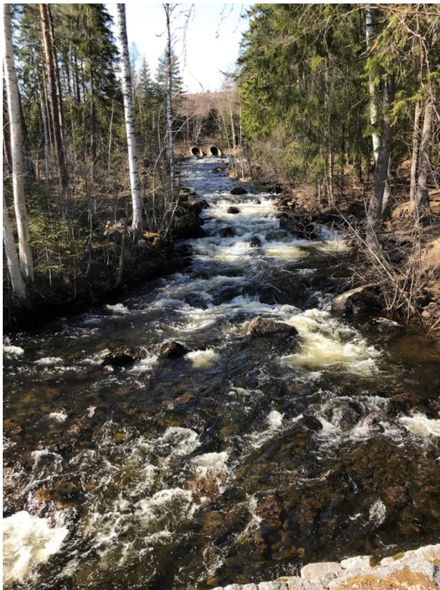
Figur 4. Foto nedströms trummor före åtgärd (fotoriktning mot nordväst). (Foto: Afry).
