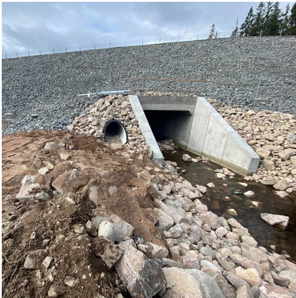
Figur 15. Foto efter åtgärd nedströms bron vid brons utlopp. Foto taget mot norr. Foto taget efter datum för efterkontroll av entreprenör. (Foto: Entry).
