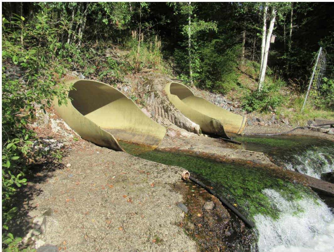
Figur 3. Foto utlopp vägtrummor före åtgärd (fotoriktning mot norr). (Foto: Afry).
