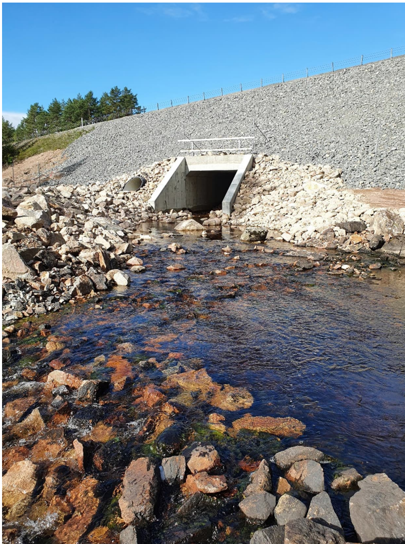
Figur 16. Foto efter åtgärd, nedströms bron, området strax nedströms brons utlopp. Tröskeln vid nederkant av poolen syns i framkant i bilden. Foto taget mot nordväst. Foto taget innan mulljord lades ut som visas på Figur 14 och Figur 15 (Foto: Afry).
