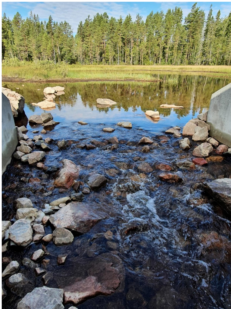
Figur 10. Foto efter åtgärd på bottenmaterialet i bron i dess inlopp. Tröskeln vid inloppet till bron syns, tillsammans med de större stenar som placerades innan inloppet i sjön. Foto taget mot nordväst. (Foto: Afry).
