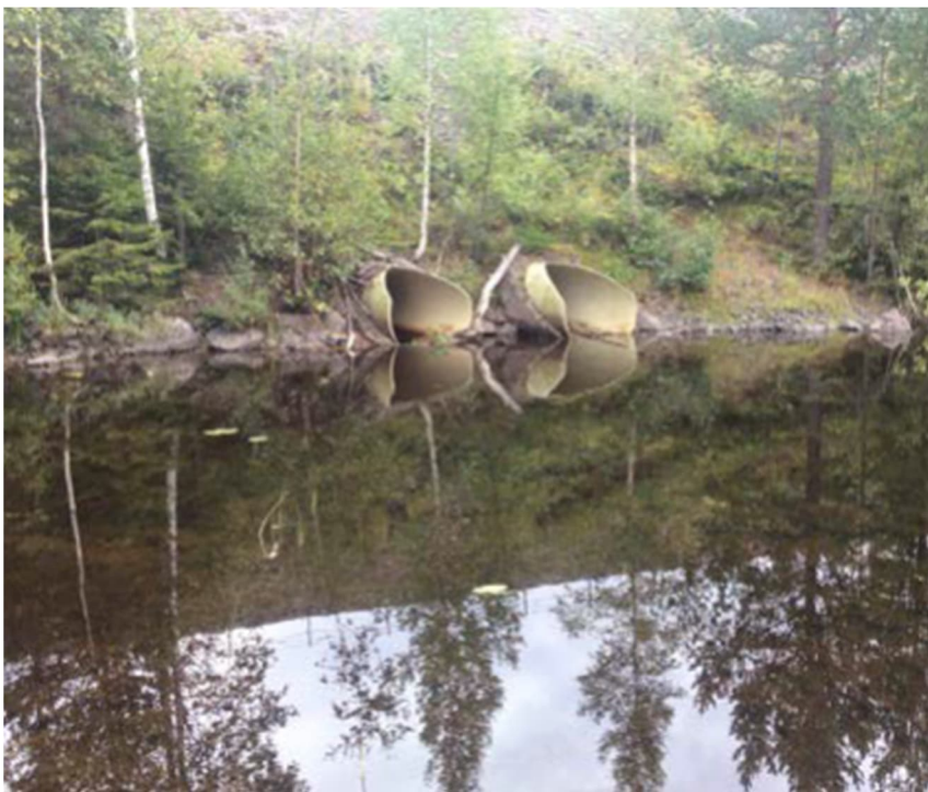
Figur 5. Foto inlopp vägtrummor före åtgärd (fotoriktning mot söder).
