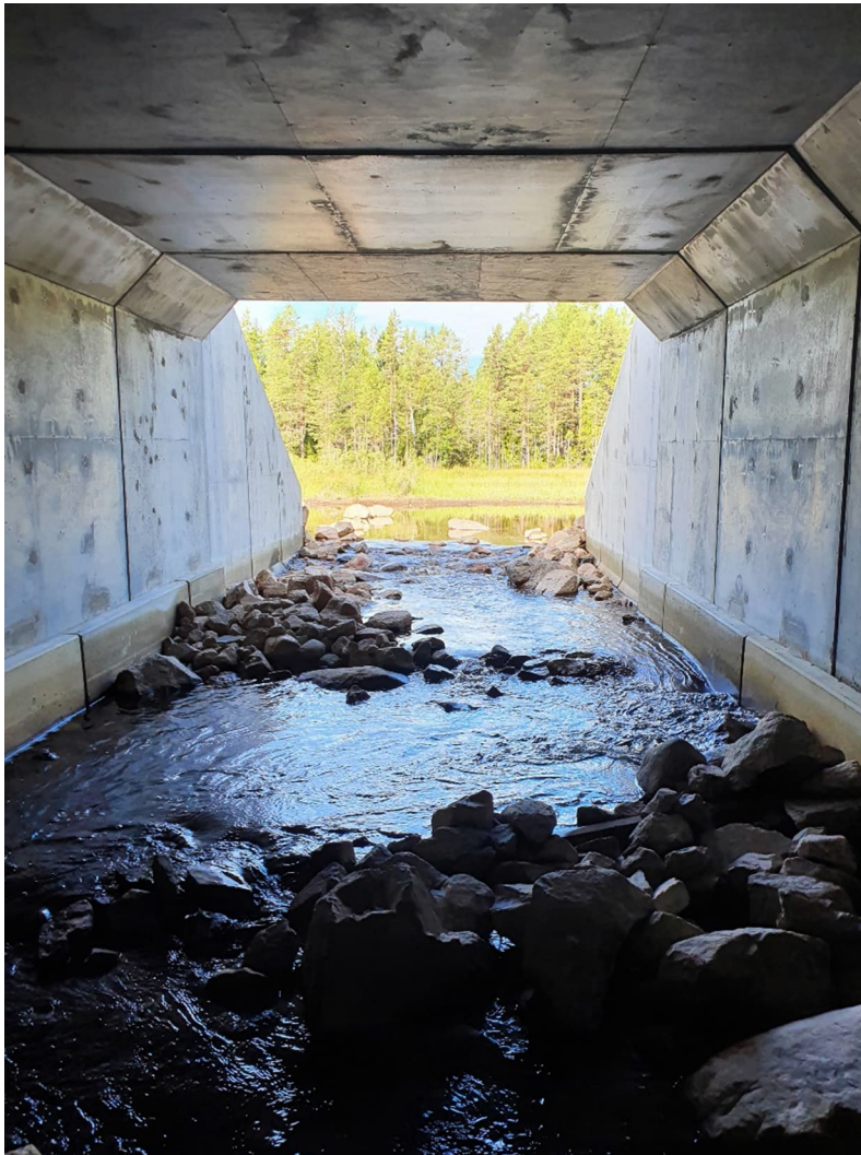
Figur 11. Foto efter åtgärd i bron, där stenmaterial och höjdskillnader (pga balkarna i brons botten) syns tydligt. Vattnet syns rinna meandrande i bron. Foto taget mot nordväst. (Foto: Afry).
