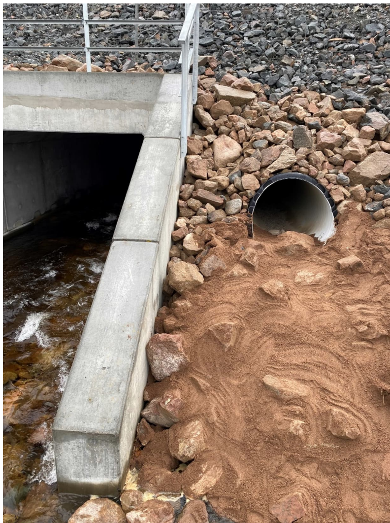
Figur 8. Foto taget uppströms bron, på faunapassagen och de markeringsstenar som leder ner till vattnet. Plattare stenar har placerats ut lite som en stig från vattnet upp mot trumman samt vid ingången till trumman. Mulljord har sedan lagts ut mellan dessa stenar. Foto taget efter Figur 7 (några stenar har flyttats på och mulljord har lagts ut). (Foto: Afry).
