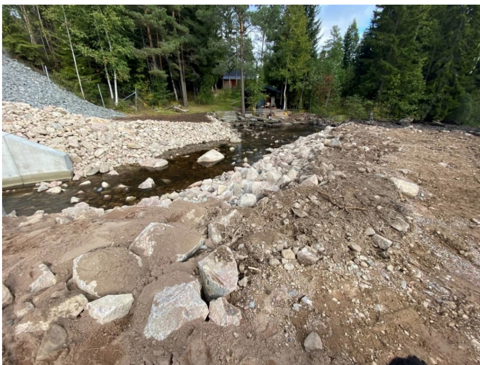
Figur 14. Foto efter åtgärd, direkt nedströms bron. Poolen vid grannfastighetens byggnad syns i bakre delen av fotot. I bakre vänstra delen av fotot syns området där de rivna trummorna hade
