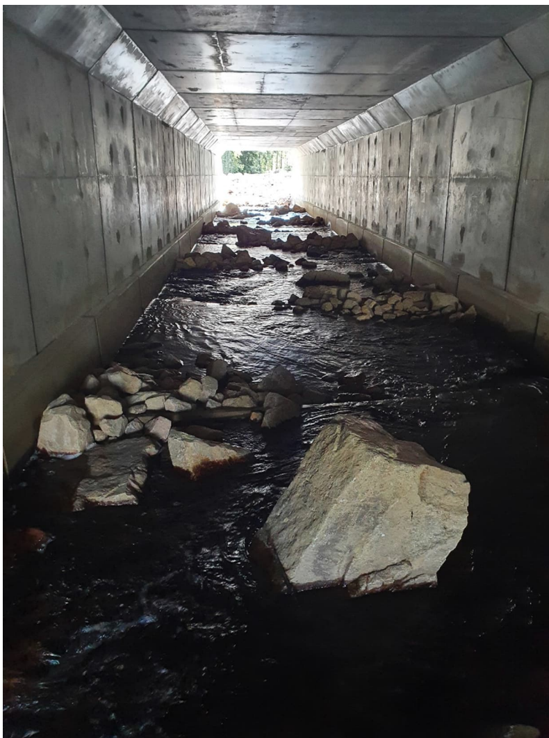
Figur 12. Foto efter åtgärd i bron. Den meandrande formen på vattnets väg, som fås tack vare fiskbalkarnas placering och stenmaterial som fyllts mot dessa, syns tydligt. Enstaka större stenar placerade i åfåran för att skapa naturliga rörelser i vattnet och skydd syns på bilden. Foto taget mot sydväst. (Foto: Afry).
